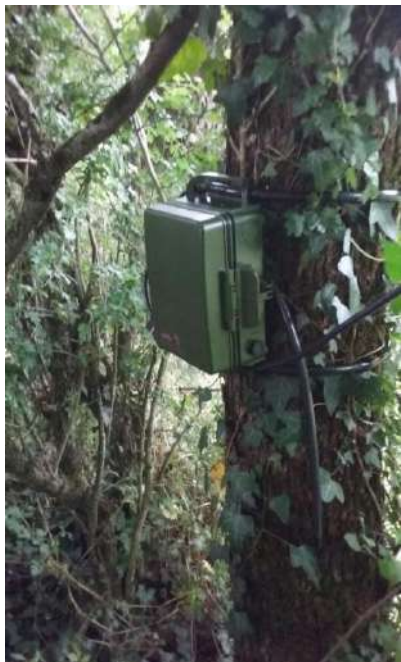
Figure 12 : Installation d'enregistreur continu SM4BAT
