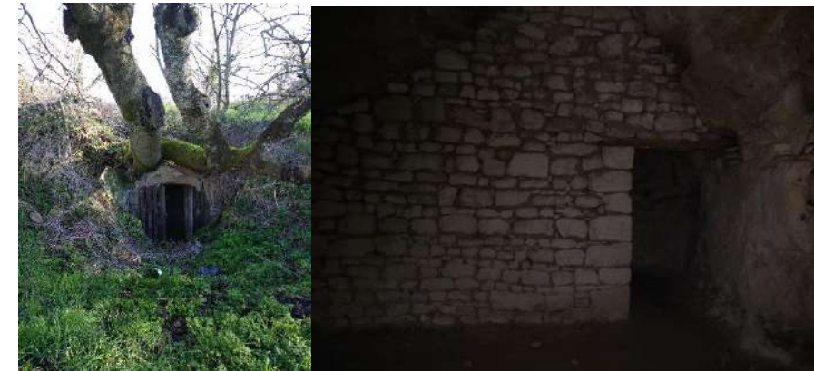
Figure 60 : Photos d'une des caves et de la maison abandonnées contrôlées aux Vaux Sainte-Marie
